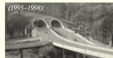
(1995–1998) Silniční tunely VMO Pražská radiála v Brně
