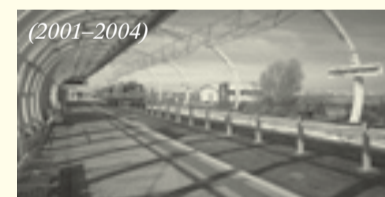
(2001–2004) Tramvajová trať Hlubočepy–Barrandov, Praha
