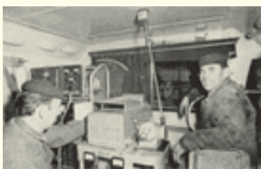
ZKOUŠKY RADIOSPOJENÍ PŘI STAVBĚ PŘIVADĚČE Z ŽELIVKY
