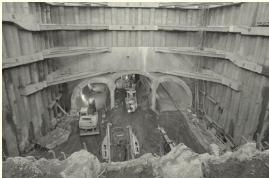
Prosinec 2012: ražba trojložní stanice metra V.A Nádraží Veleslavín, Praha
