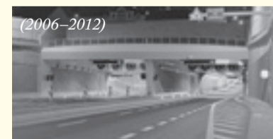
(2006–2012) Silnice I/42 Brno, VMO Dobrovského B
