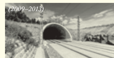
(2009–2013) Modernizace trati Votice – Benešov u Prahy
