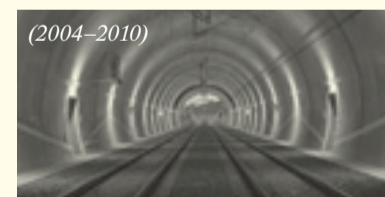
(2004–2010) Nové spojení (tunel pod pražským Vítkovem)
