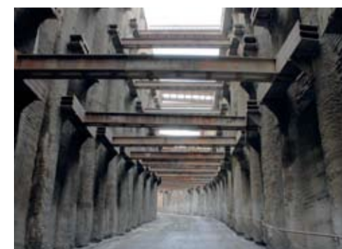
Sjízdná rampa vedoucí do hloubené jámy Veleslavín
