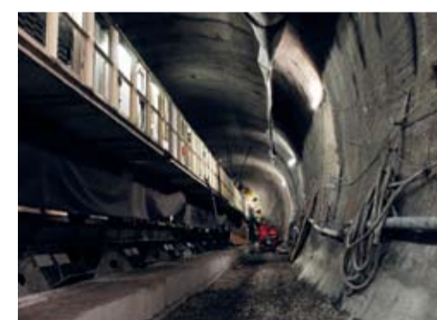
Razicí štít Tonda v levém staničním tunelu
