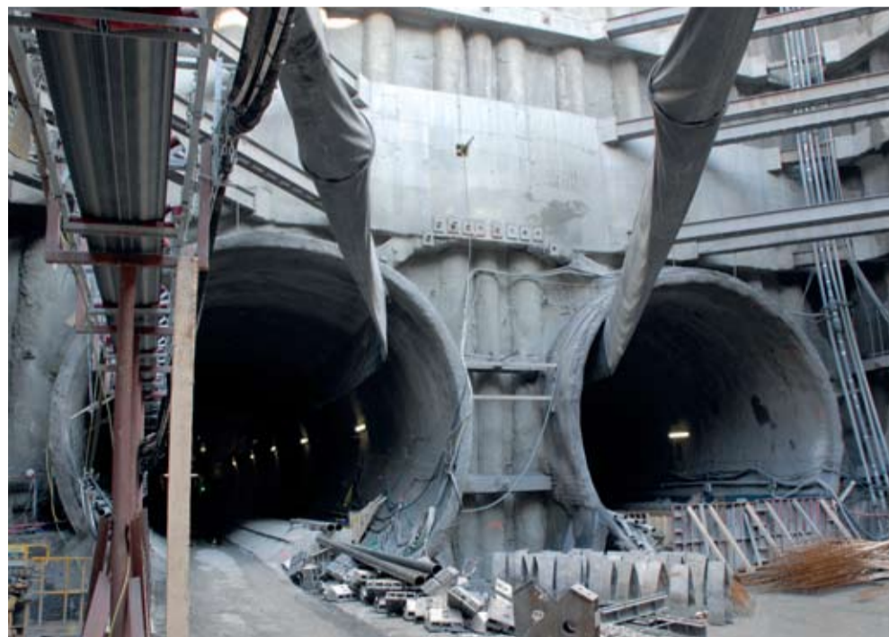
Portál ražené části stanice Veleslavín s již patrným definitivním trojlodním profilem
