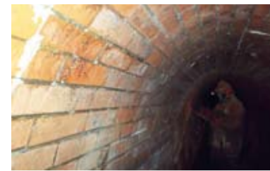
KANALIZACE NA SMÍCHOVĚ PROCHÁZÍ REKONSTRUKCÍ
