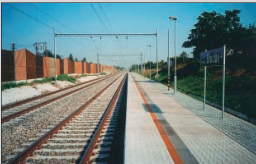
Nová zastávka v Moravském Písku na II. železničním koridoru
