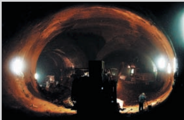
Rozplet západní tunelové roury tunelu Mrázovka v Praze
